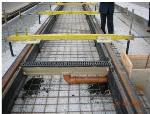
Figura o.24 Detalle del Drenaje Transversal
